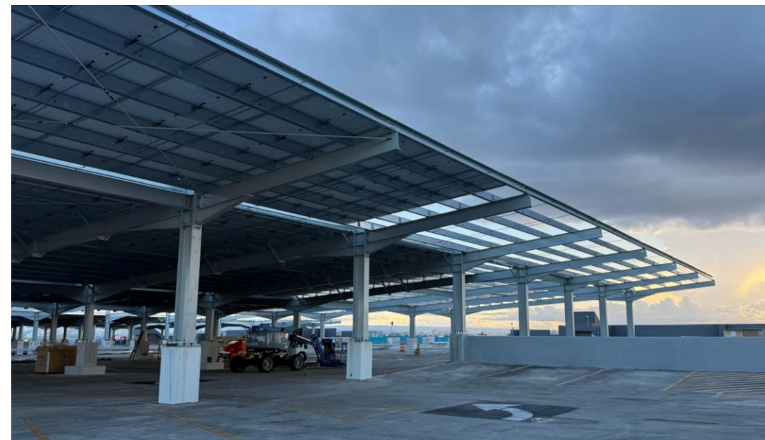
Figura 23. Fotografía de la instalación de paneles “Aeropuerto en Puerto Rico” Fuente: Skysense (2025).
