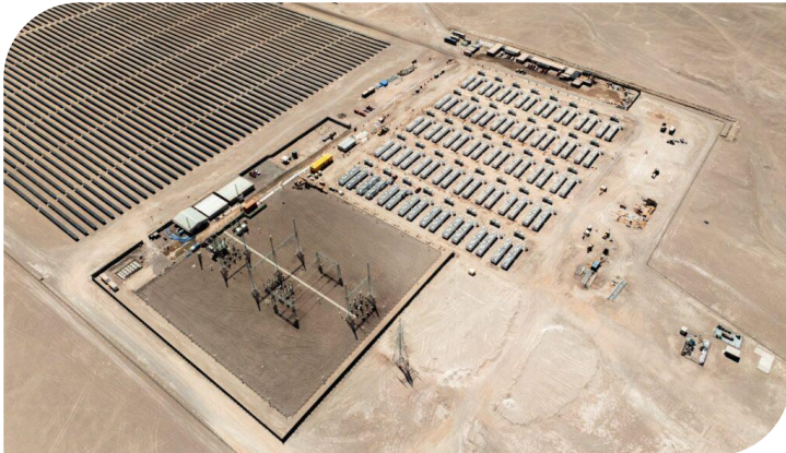
Figura 17 Proyecto Desierto – Chile Fuente: Atlas Renewable Energy (2024).
