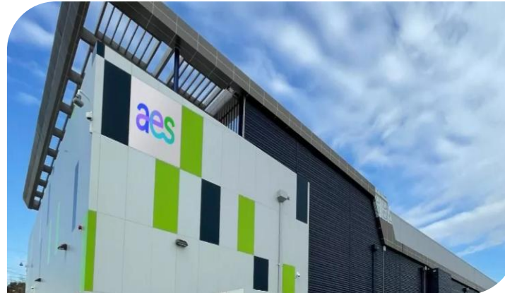
Figura 18 AES Alamos – EE. UU. Fuente: AES Corporation (2024)
